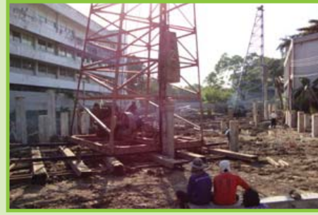
งานตอกเสาเข็มส่วนที่เหลือแล้วเสร็จ
