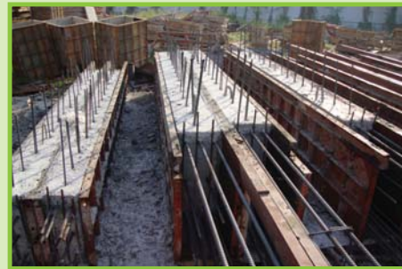
งานเทคาน Pre Cast เพื่อเตรียมติดตั้ง
