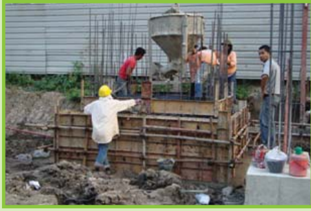
งานหล่อคอนกรีตบ่อลิฟต์
