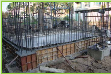
งานบ่อน้ำใต้ดินดำเนินการแล้วเสร็จ 70%
